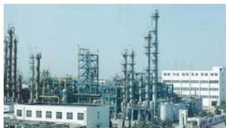
中国では排ガス中硫黄酸化物などによる大気汚染が社会問題となっていた。このため、排ガス中硫黄酸化物などの規制が強化された。当社は、グループ会社の日揮触媒化成の乾式脱硝技術と北海道電力の乾式脱硫技術を組み合わせて、世界初の低温から中温の排ガス向けの乾式脱硝・脱硫システムを開発し、中国のパートナー企業とともにコークス製造プラントの中温排ガス向けに数多くの技術供与を行っている。<sup>(14)</sup> 図-13 にその一例を示す。このように当社は、日中のパートナーとともに中国環境問題のソリューション提供を実現している。さらに当社は、中国だけでなく、インドなど、排ガスによる大気汚染が課題となってい
